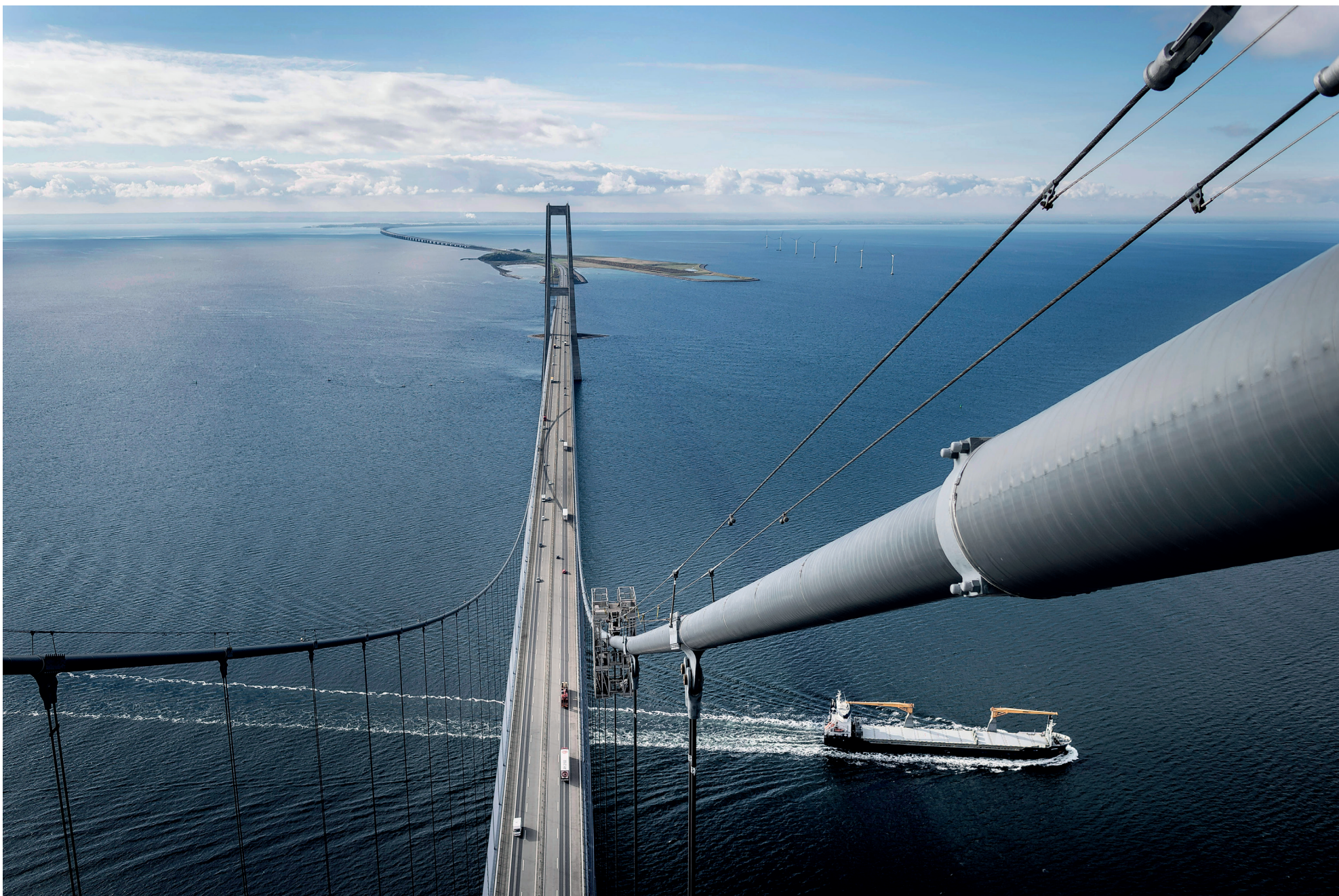
Langt ned. Storebæltsbroen set fra toppen. Foto: Katrine Becher Damkjær
