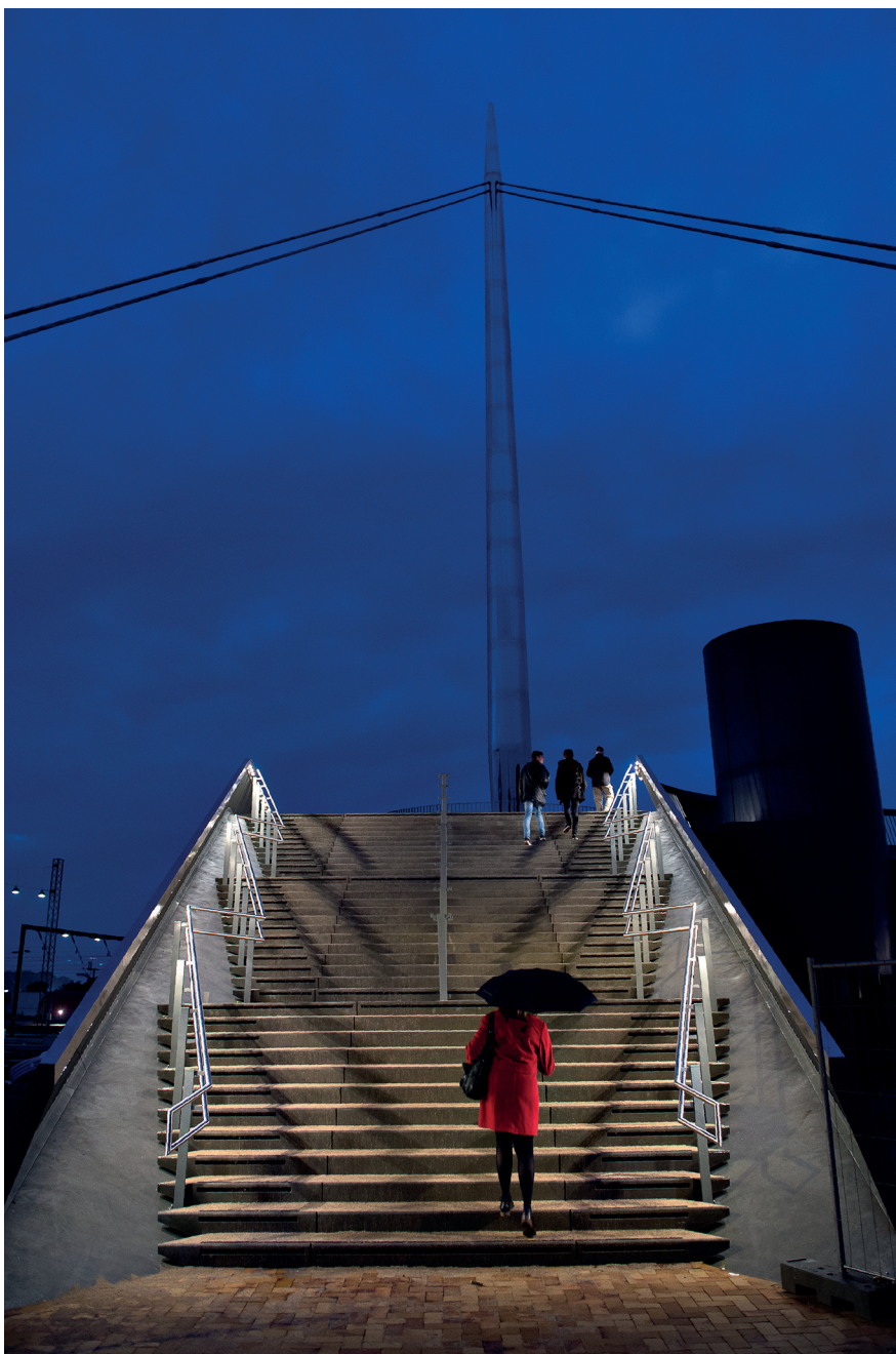
Byens Bro. ECCS (European Convention for Constructional Steelwork) har tildelt Byens Bro i Odense en ærespris for kreativ og enestående brug af stål. Byens Bro snor sig elegant over jernbanens mange spor og perroner og forbinder by og havn for fodgængere og cyklister. Om aftenen og natten får broen et helt anderledes udtryk, der bestemt er værd at opleve. Foto: Kim Rune Jessen
